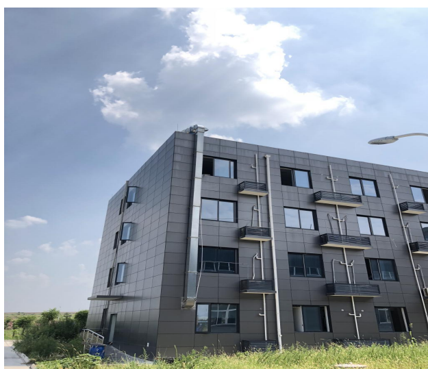
食堂油烟排气筒
